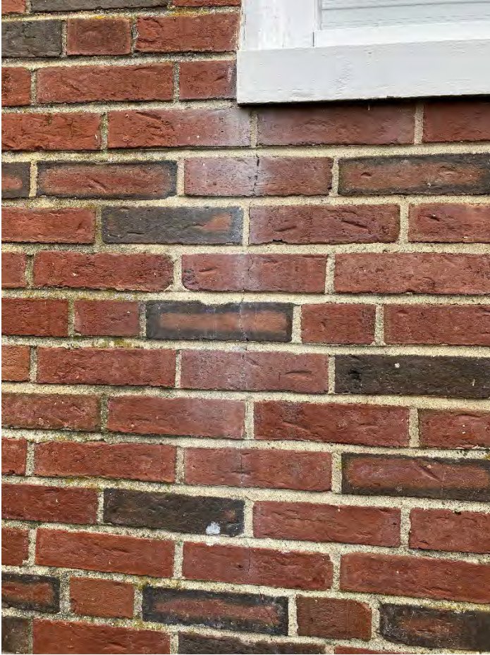
CRACK BELOW M. O.
